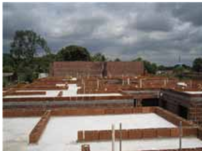
Construção de 400 UH em Novo Redentor – Camaragibe
