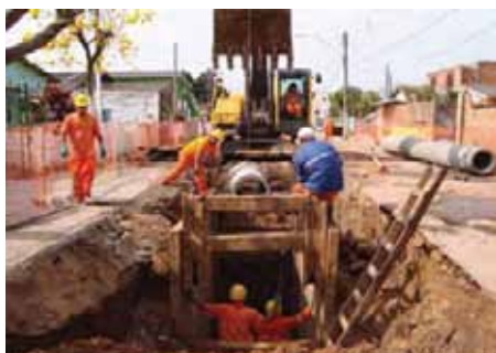
Assentamento de interceptor em Esteio/Sapucaia
