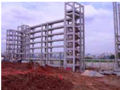
Construção de 880 UH na Gleba K
