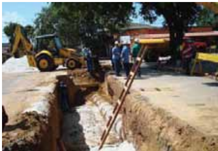
Adutora em execução
