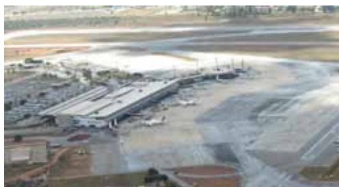
Reforma e Ampliação Sul do TPS
