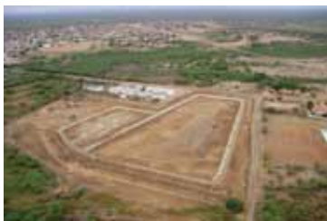
Construção da ETE – Belém do São Francisco/SE
