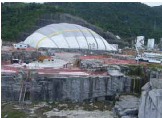
Usinas – vista geral
