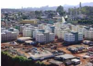
Construção de UH em Contagem
