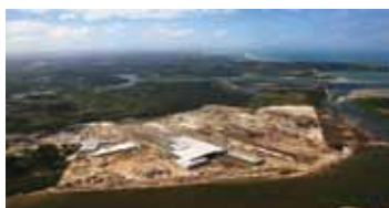
Construção do Estaleiro Atlântico Sul
