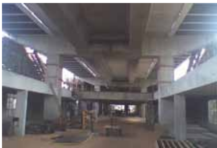
Construção da nova estação de Parangaba
