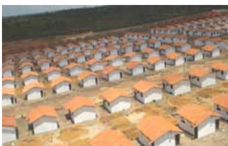
Construção de UH
