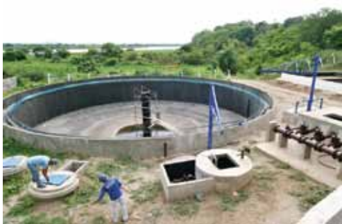
Decantador da ETE Olaria
