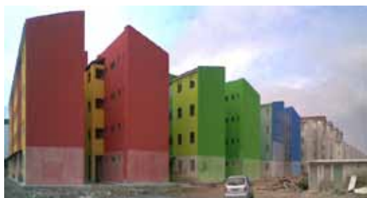
Construção de 352 UH no bairro da Imbiribeira
