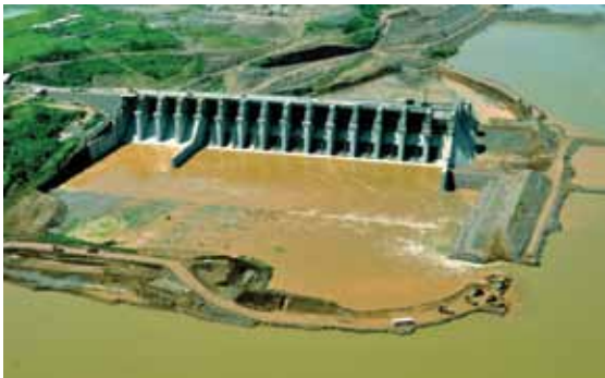
Vista do Vertedouro – Margem Direita
