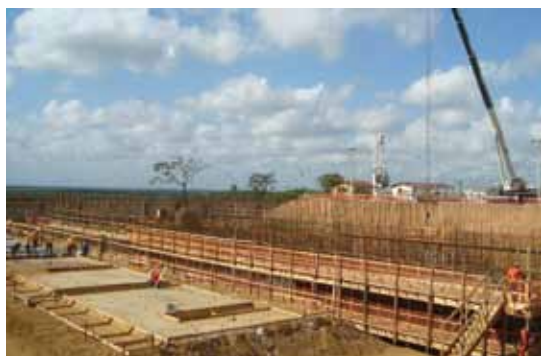
Ampliação da ETA Gramame
