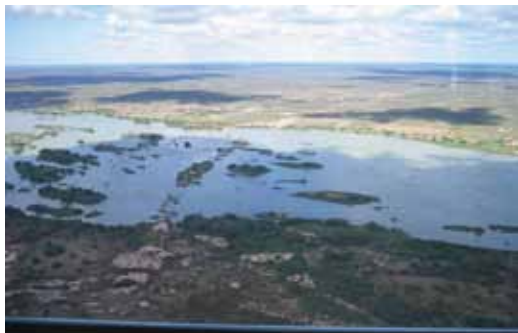
Região Eixo Aproveitamento Hidrelétrico Pedra Branca
