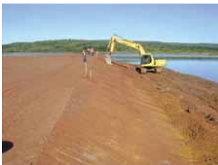
Terraplenagem no talude do aterro da captação – GO
