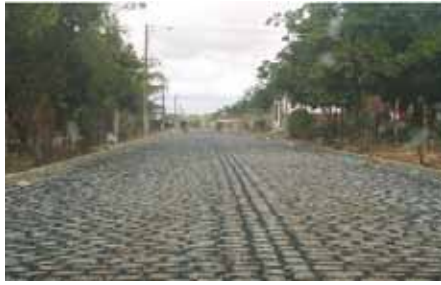
Obras de pavimentação na Av. Couto Magalhães
