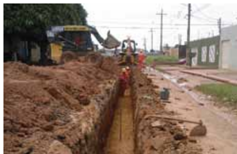
Rede coletora em execução
