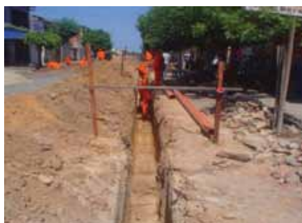
Assentamento de rede na Rua Francisco Glicério – Bacia SD-6
