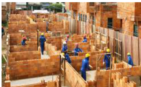
Construção de UH
