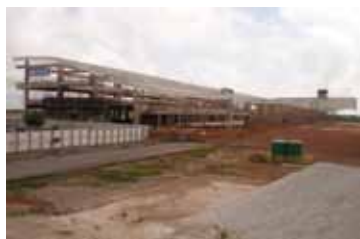
Construção novo terminal de passageiros
