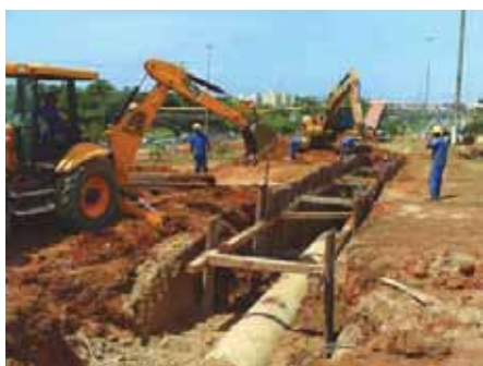
Assentamento de linha de recalque em Salvador
