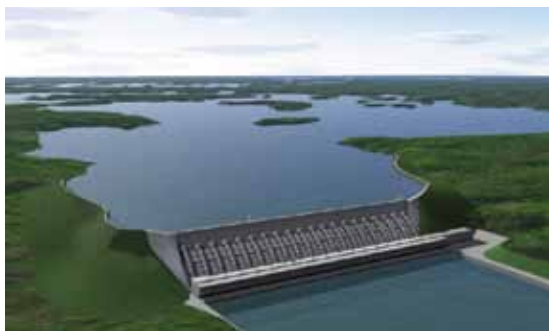
Casa de Força Principal
