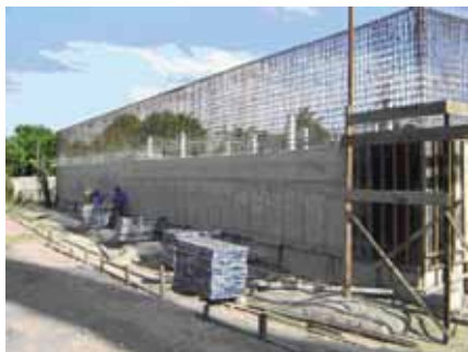
Construção do reservatório Buritis
