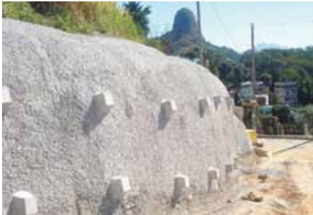
Contenção de encosta para construir via para microtrator em Romão
