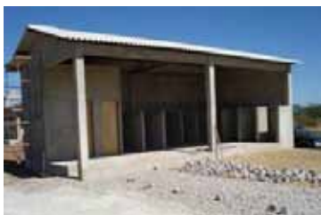
Galpão de triagem em Ibimirim/PE
