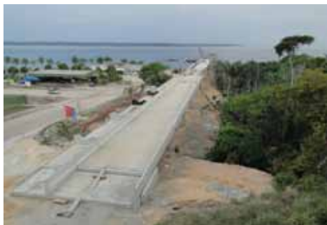
Ponte para adução de água na captação do Rio Negro
