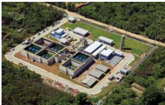
Estação de Tratamento de Esgoto em Mongaguá
