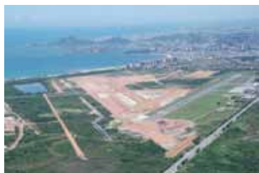
Construção novo terminal de passageiros
