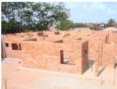
Construção de 264 UH verticais - Terreno 1
