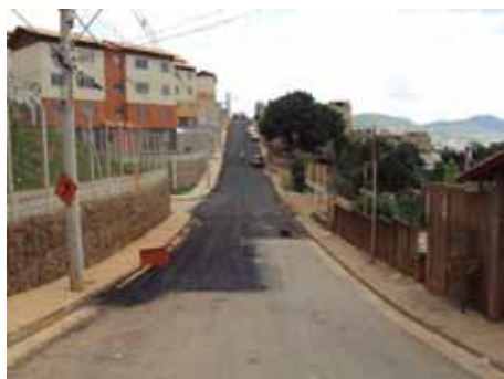
Pavimentação e UH no Aglomerado Morro das Pedras
