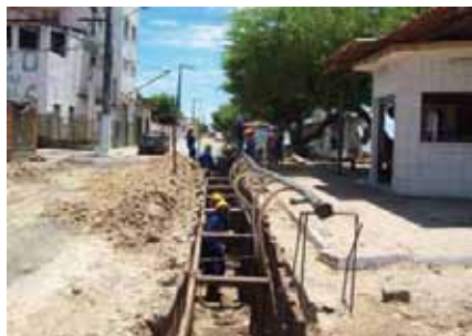
Assentamento de redes coletoras em Barra dos Coqueiros
