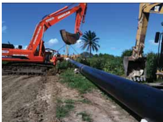
Obras no gasoduto
