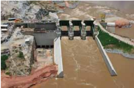
Vista do Vertedouro
