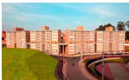
UH concluídas no Conjunto F- Núcleo Grotão
