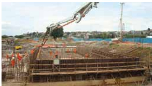
Construção da ETE São João
