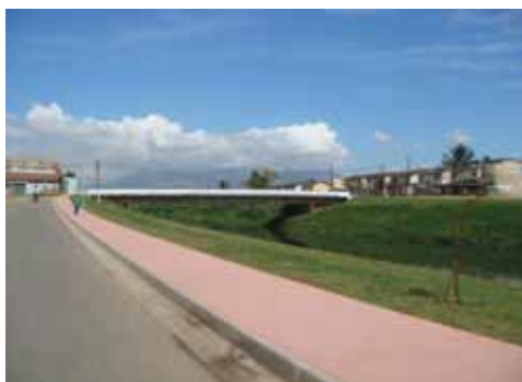
Visão da Avenida Beira Rio urbanizada, em Belford Roxo
