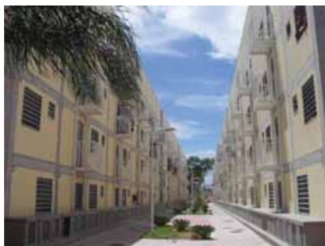
Unidades Habitacionais concluídas - DSUP
