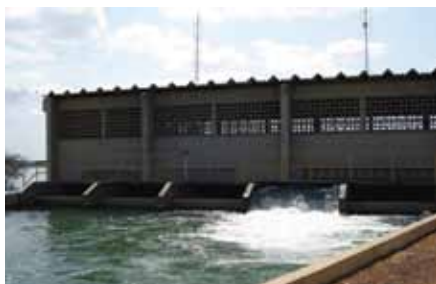
Estação de Bombeamento
