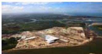
Construção do Estaleiro Atlântico Sul
