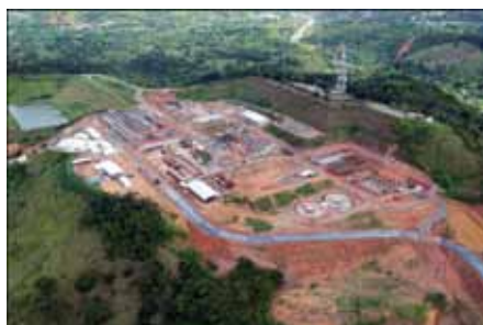
Estação de Tratamento de Água
