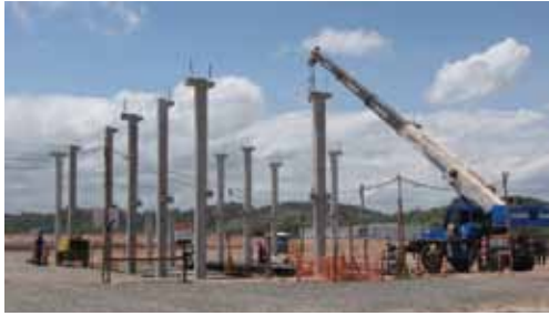
Construção da Casa de Força
