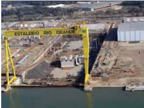
Obras do Estaleiro Rio Grande
