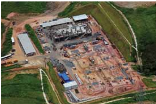
Construção da subestação transformadora
