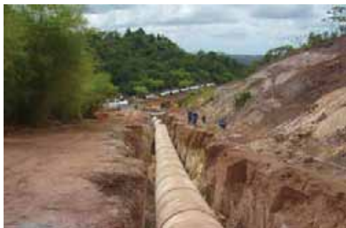
Assentamento da Adutora de Água Bruta
