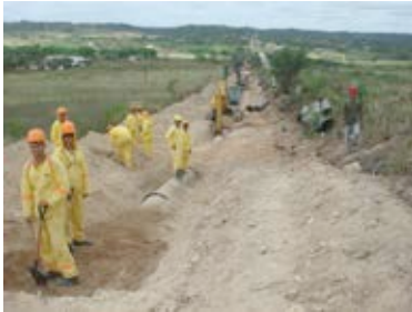
Obras de implantação da adutora
