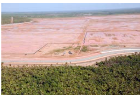
Terraplenagem da Refinaria Premium I
