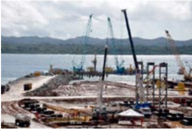
Construção do Estaleiro Enseada do Paraguaçu
