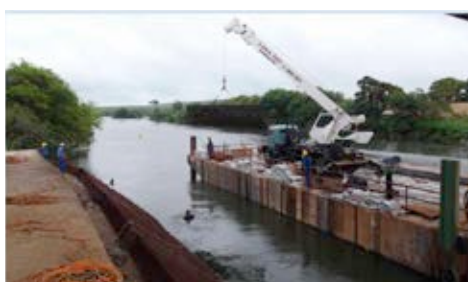
Canal de Igarapu – Detonação para remoção de pontos altos no canal
