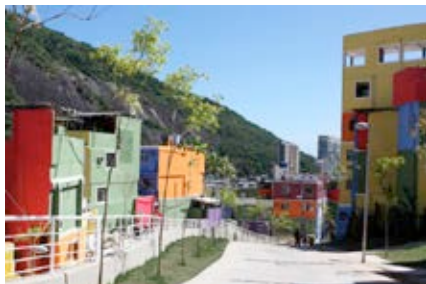
Urbanização na Rocinha, Rua 4
