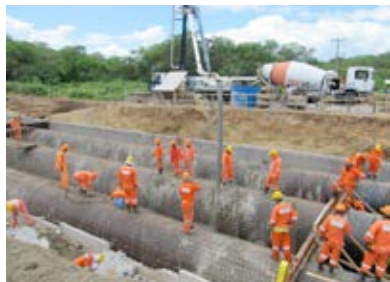
Obras de assentamento dos canais
