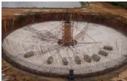
Concretagem da Laje do Fundo do Decantador 2 São Francisco do Conde
