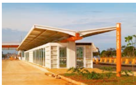
Estação Granja do Ipê – BRT Eixo Sul – Brasília/DF
