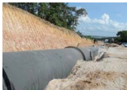
Implantação da adutora de água bruta
