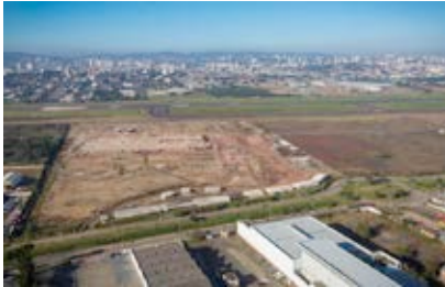
Construção do novo Terminal de Cargas
