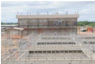
Estação de Tratamento de Esgoto de Petrolina/PE
