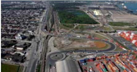
Vista da obra
