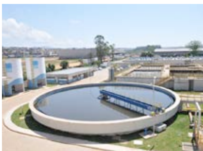
ETE São João - obras concluídas
