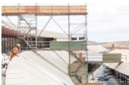
Reforma e modernização do TPS
