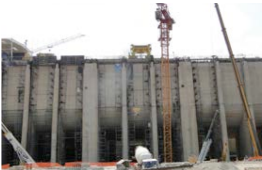
Casa de Força – vista de jusante
