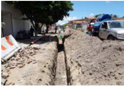
Implantação de redes coletoras no bairro Parangaba
