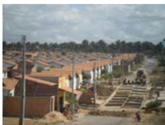
Unidades habitacionais e infraestrutura viária
