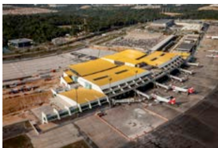
Reforma e ampliação do TPS
