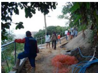
Abertura de vias de acesso
