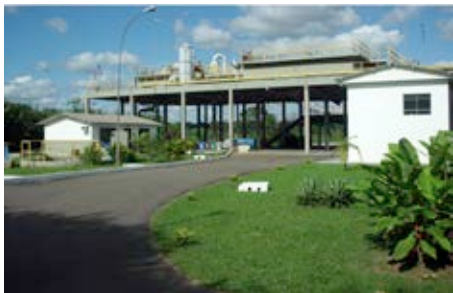
ETE São Francisco
