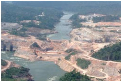
Casa de Força – Vista Geral
