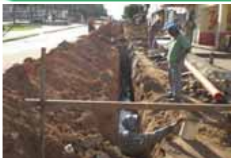
Assentamento de rede coletora
