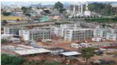
Construção de unidades habitacionais em Contagem
