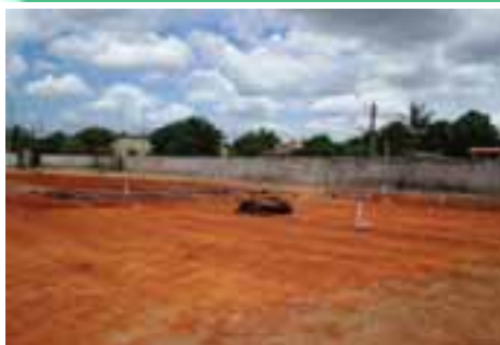
Local de construção do reservatório
