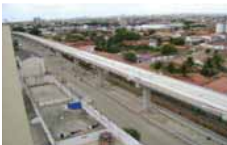
Elevado de Parangaba e estação a ser rebaixada
