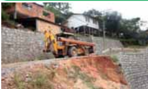
Obras de contenção
