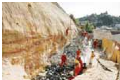
Obras de contenção no bairro Caixa D'Água – Olinda
