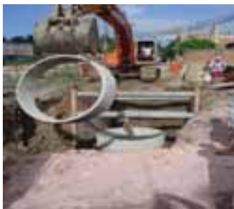
Obras de Infraestrutura na Comunidade Entre Rios
