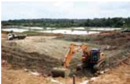
Ampliação da ETE Mocambo – Itaparica
