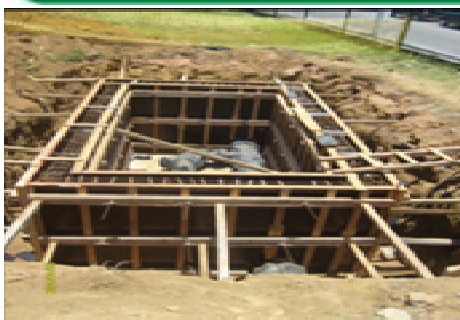
Construção de caixa para a estrutura de controle
