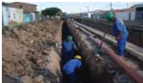
Jeremoabo-BA – abertura de vala para instalação da rede convencional
