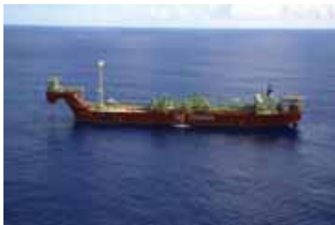
Navio Plataforma FPSO Cidade de São Vicente
