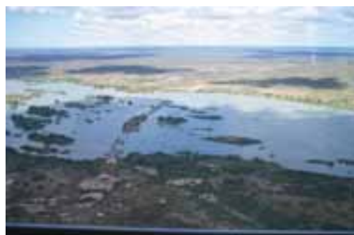
Região Eixo Aproveitamento Hidrelétrico Pedra Branca
