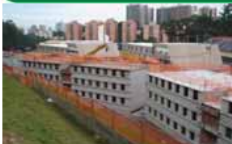
Construção de unidades habitacionais no Conjunto F
