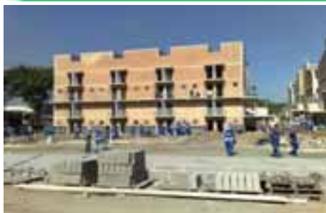
Construção de unidades habitacionais da Av. Itaóca 1.174
