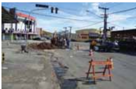
Obra de esgotamento sanitário em Guarulhos
