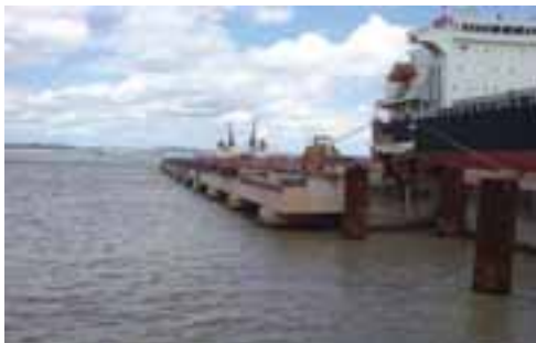
Cais do Porto de Itaqui
