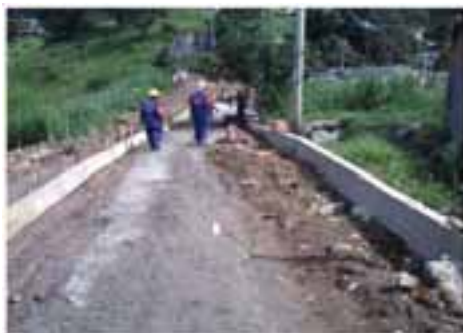
Construção de rampa – Escola José Caetano da Silva
