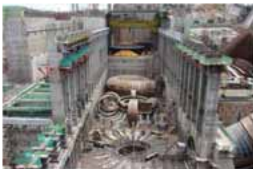
Casa de Força – vista geral
