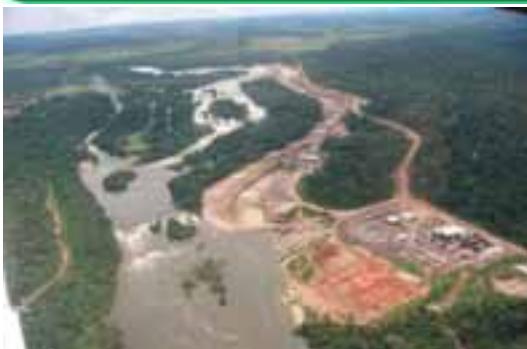
Conduto Forçado – vista geral
