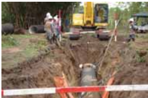
Assentamento de adutora de água bruta
