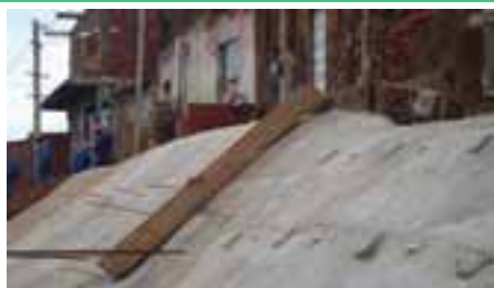
Obra de contenção de encostas em Alto de Ondina
