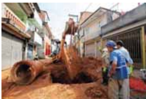
Obras de infraestrutura na Gleba K
