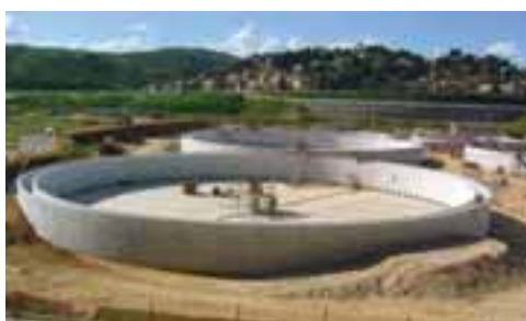
Obras na ETE Onça – Belo Horizonte
