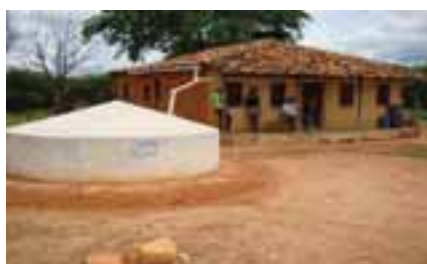
Cisterna de Placa
