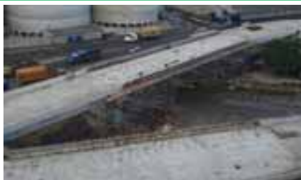
Viaduto da João Pessoa
