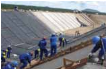
Revestimento de canal do lote 1 – Eixo Norte
