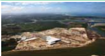
Construção do Estaleiro Atlântico Sul
