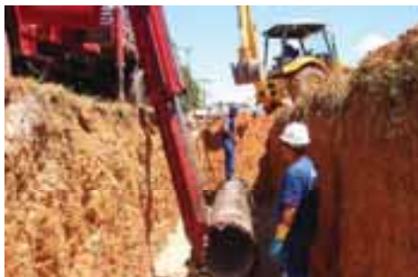
Adução em execução
