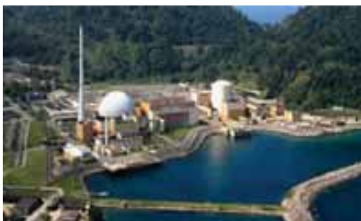
Usinas – vista geral
