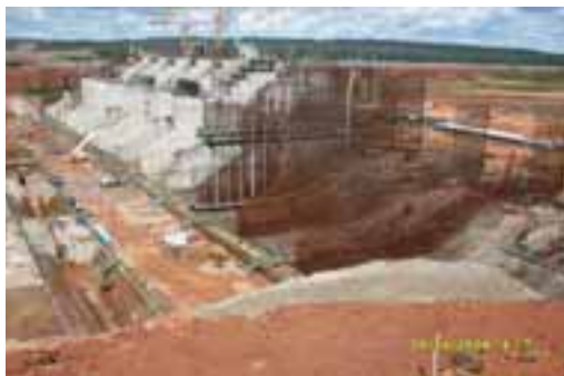
Vertedouro – vista de jusante
