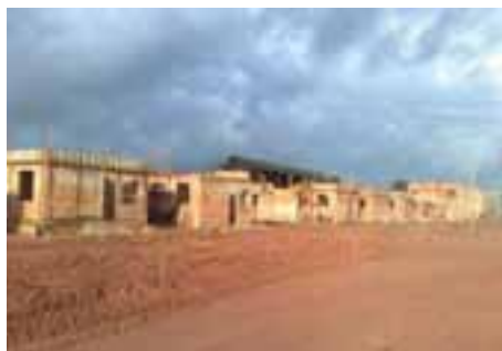
Conjunto Habitacional em Jaderlândia
