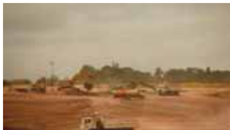
Refinaria Abreu e Lima – terraplanagem
