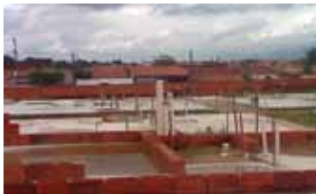
Alvenaria de elevação no Residencial Oscar Araripe
