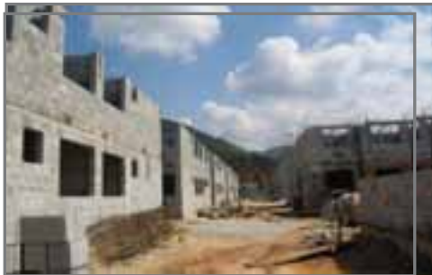
Construção de unidades habitacionais em Mesquita
