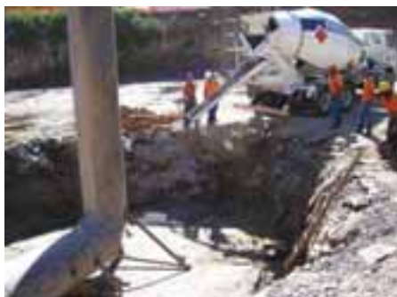
Concretagem da base do decantador da ETE
