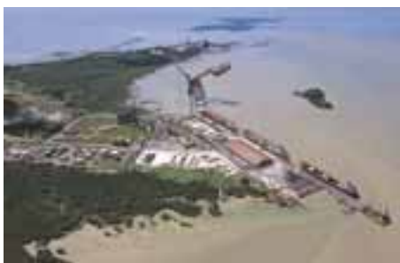
Cais do Porto de Itaqui
