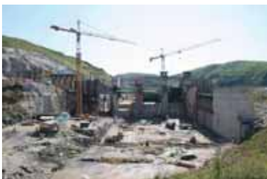
Casa de Força – vista geral
