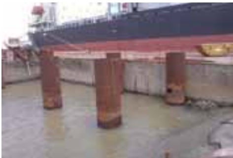
Cais do Porto de Itaqui
