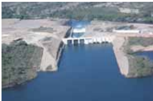
Montante – vista geral
