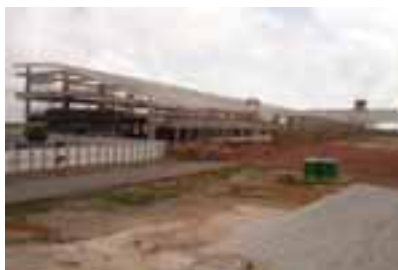
Construção novo terminal de passageiros
