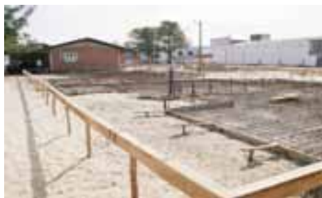
Execução da fundação "radier" de 264 unidades habitacionais verticais – Terreno 1
