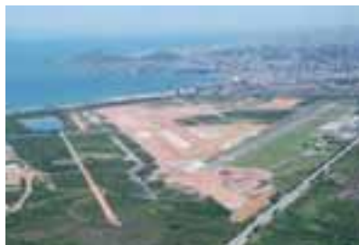
Construção novo terminal de passageiros
