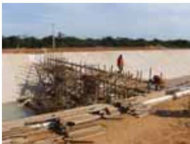
Construção de Passarela
