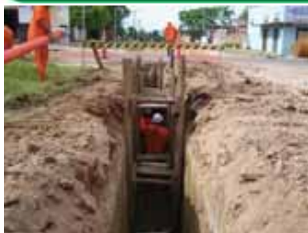
Assentamento de redes – Alvorada/Viamão
