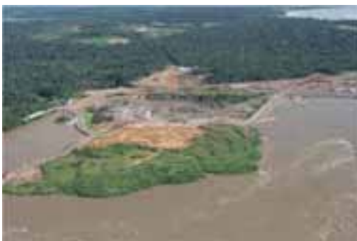
Margem direita - vista geral
