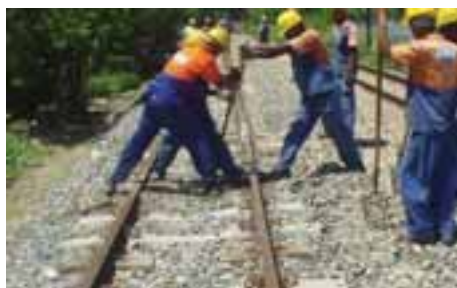
Recuperação da via permanente
