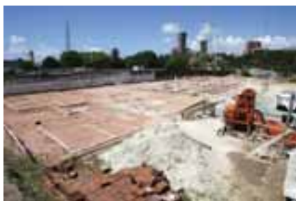
Fundações das unidades habitacionais
