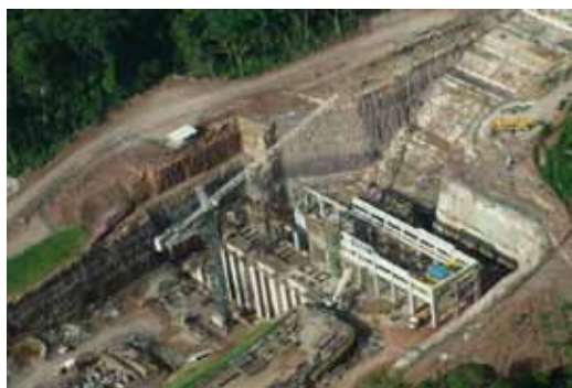
Vista aérea da obra
