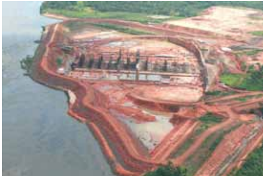
Vista aérea da obra
