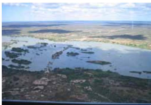
Região Eixo Aproveitamento Hidrelétrico Pedra Branca
