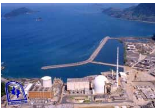
Vista geral das usinas
