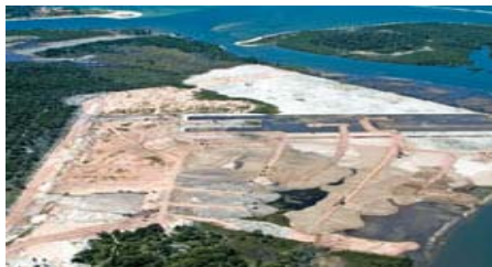
Construção do Estaleiro Atlântico Sul
