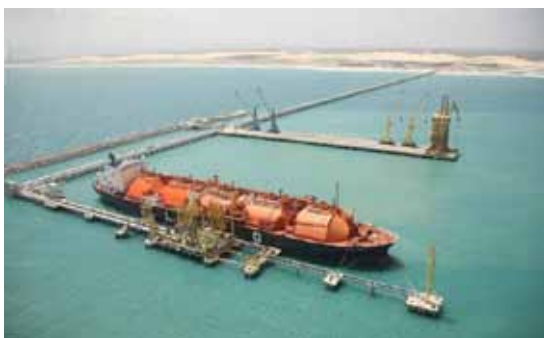
Vista geral do píer
