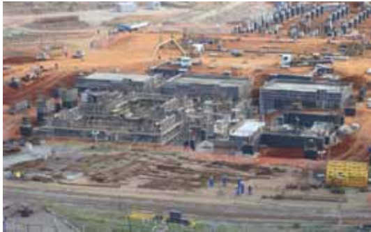
Vista aérea das obras
