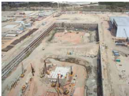
Construção do Dique Seco
