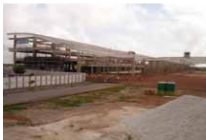
Construção novo terminal de passageiros
