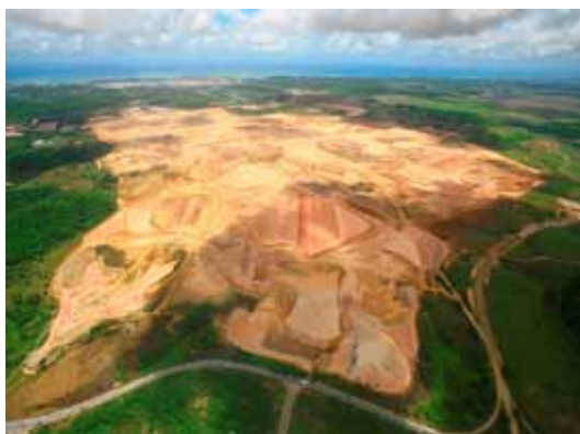
Refinaria Abreu e Lima - terraplanagem
