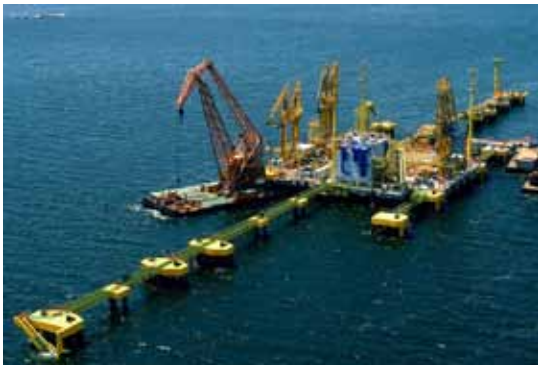
Vista geral do píer
