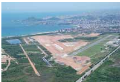
Construção novo terminal de passageiros
