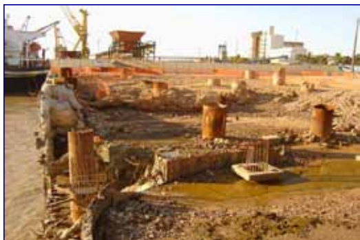
Cais do Porto de Itaqui
