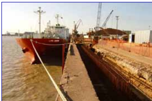
Cais do Porto de Itaqui
