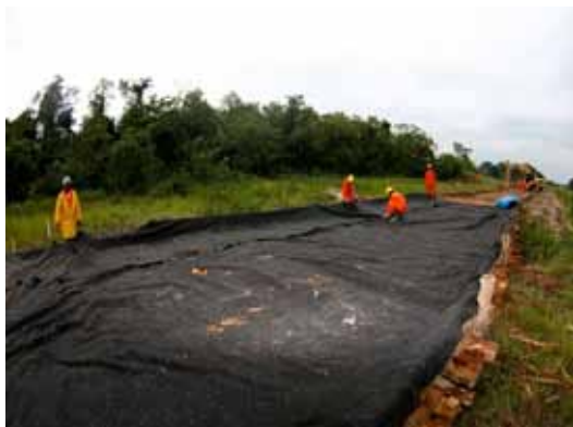
Gasoduto GASDUC III
