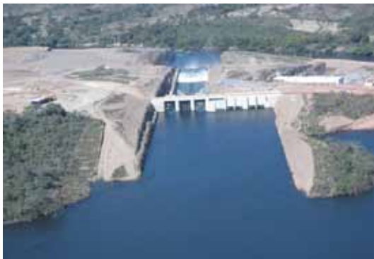
Vista geral de montante
