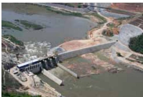
Visão Geral – Barragem e Vertedouro
