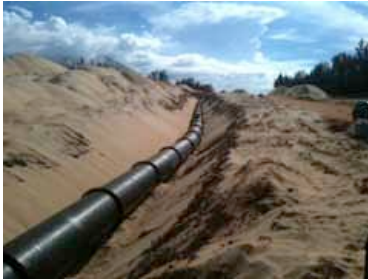
Assentamento de tubulações
