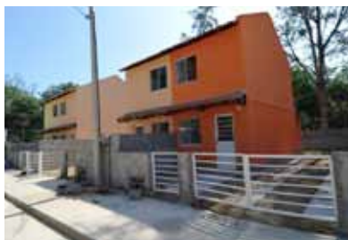
Urbanização da comunidade Dois Irmãos
