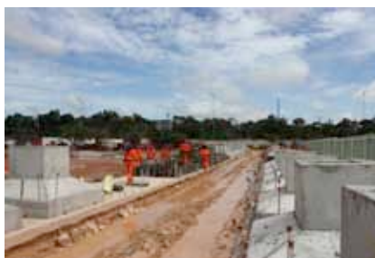
Reforma e ampliação do TPS
