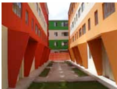
Construção do Habitacional 1
