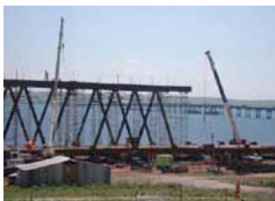
Montagem da estrutura metálica do novo vão – SP-333
