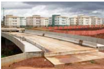
Produção de UH e construção de ponte
