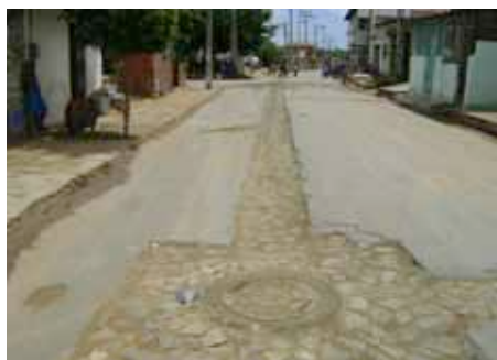
Rede coletora concluída antes da pavimentação em Passaré
