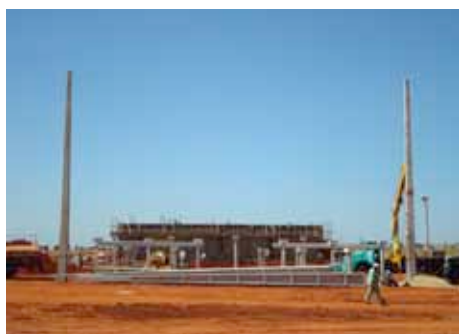
Obras civis da UFN III
