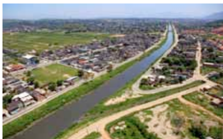
Desassoreamento do Rio Botas – Belford Roxo
