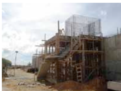
ETE ERQ Sul
