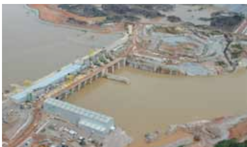
Casa de Força e Vertedouro
