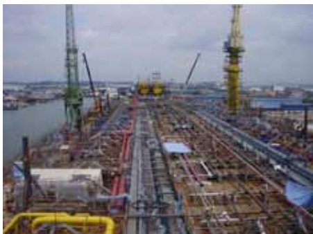
Montagem do convés do FPSO Paraty
