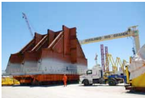
Construção do casco da P-66
