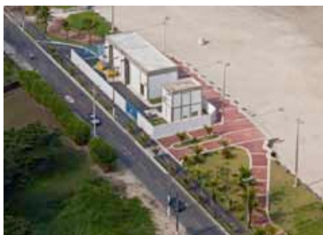
Estação elevatória de esgotos EEE7 em Praia Grande
