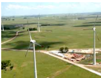
Parque Eólico Cerro Chato
