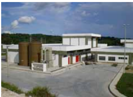
Edifício de controle operacional da ETA
