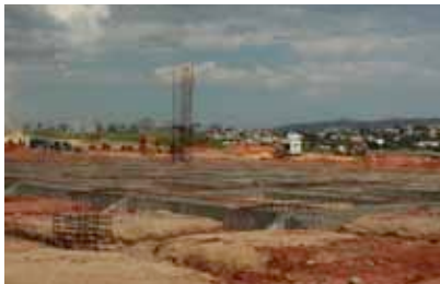
Construção do novo Terminal de Cargas
