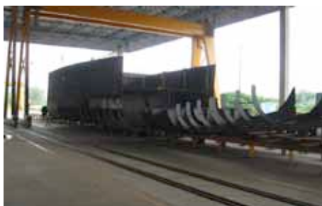
Estaleiro Superpesa – Montagem dos Blocos
