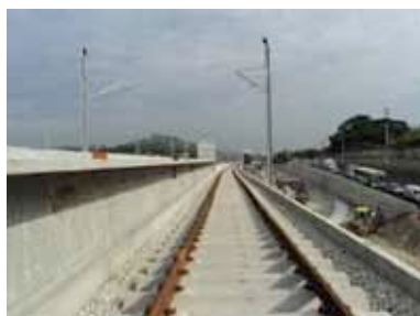
Elevação da via férrea
