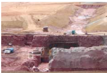
Vista Cut-Off - Barragem, Vertedouro e Casa de Força
