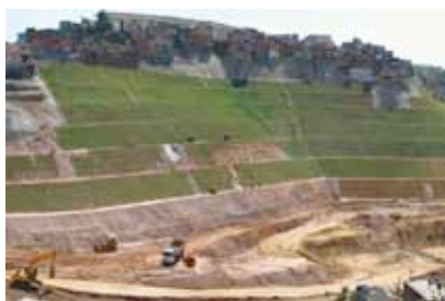
Contenção de encostas no Morro dos Macacos
