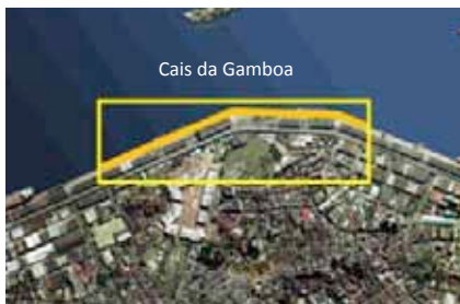
Vista aérea Porto do Rio
