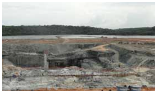
Escavações em Rocha – Vista Geral
