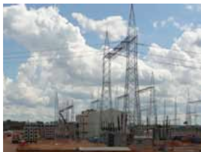
Casa de comando e prédio de válvulas
