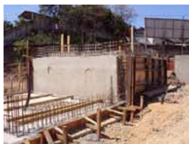
Execução de estação elevatória de esgotos
