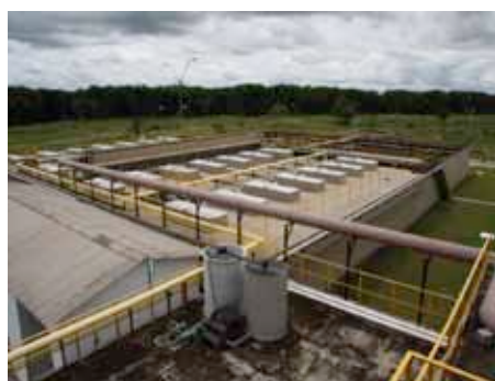
ETE São Francisco
