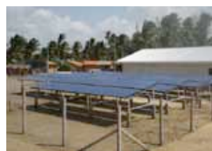
Ilha Grande / MA – miniusina a energia solar sistema isolado
