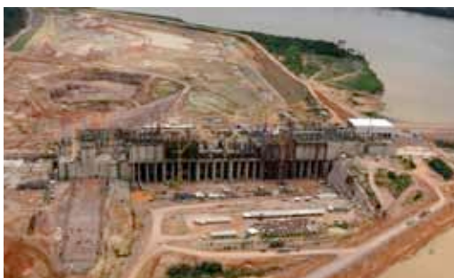
Casa de Força Margem Esquerda – Vista Montante
