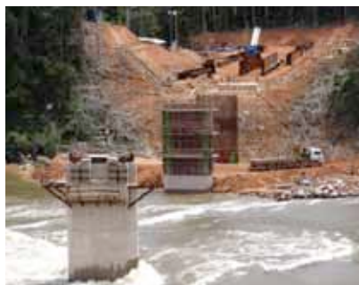
Ponte na margem direita do rio Teles Pires
