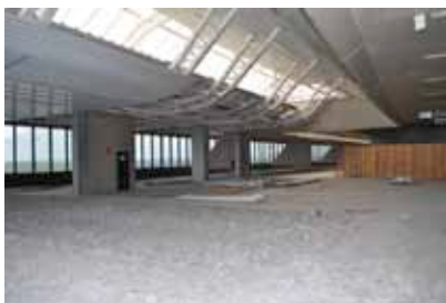
Reforma e modernização do TPS
