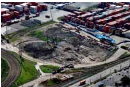
Vista aérea da obra
