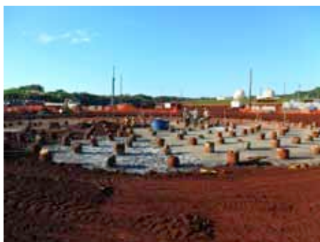
Fundação do Tanque de Armazenamento
