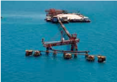
Ampliação do Terminal Salineiro de Areia Branca
