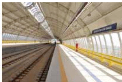
Estação Rio dos Sinos
