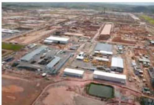
Instalações da Refinaria Abreu e Lima
