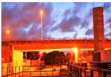
Viaduto Nereu Ramos e Estação Vila Pery
