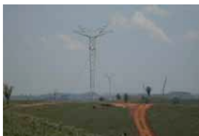
Primeiras torres da Interligação – C1
