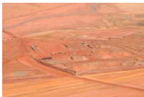
Terraplenagem da Refinaria Premium I
