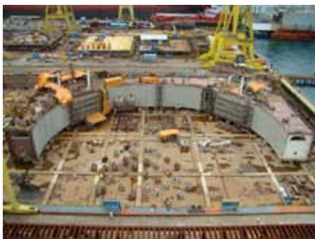
Construção do casco da P-61
