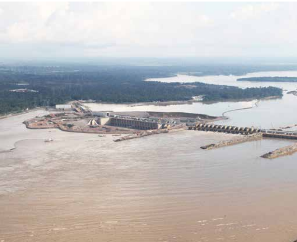
Vista geral da UHE Santo Antônio (RO) no rio Madeira
