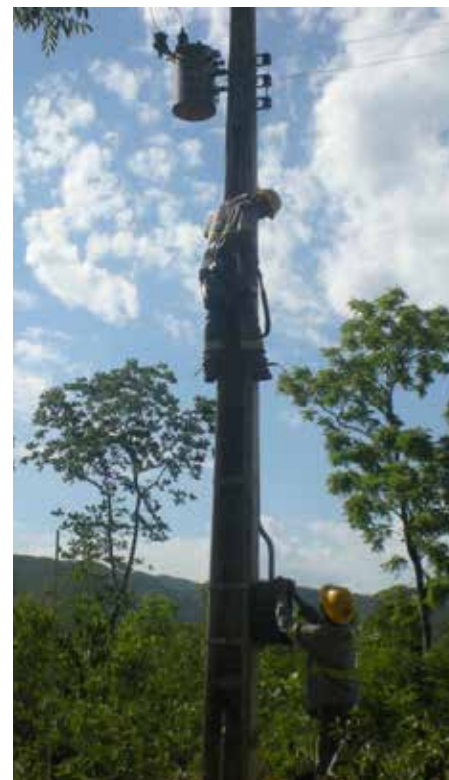
Início das obras na comunidade Quilombola Kalunga do Vão das Almas
