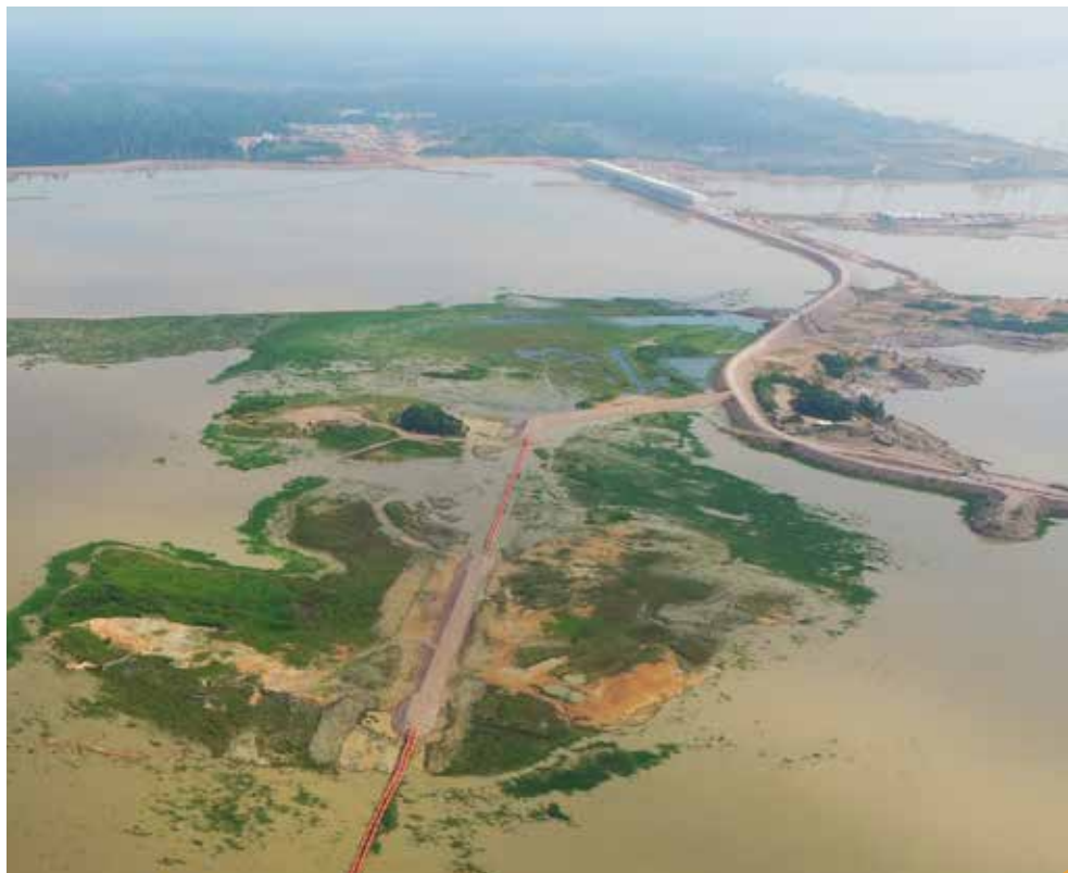
Vista geral da UHE Jirau (RO) no Rio Madeira
