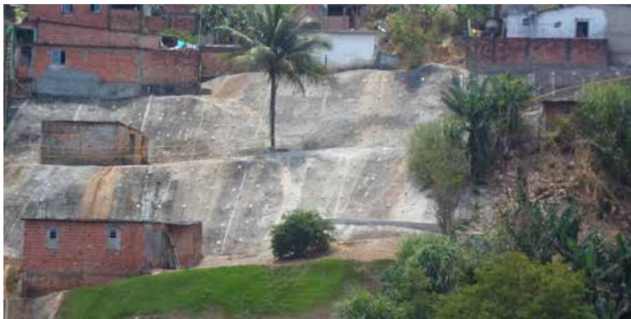
Contenção de encostas em Salvador (BA)
