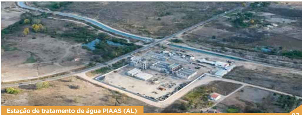
Estação de tratamento de água PIAAS (AL)
