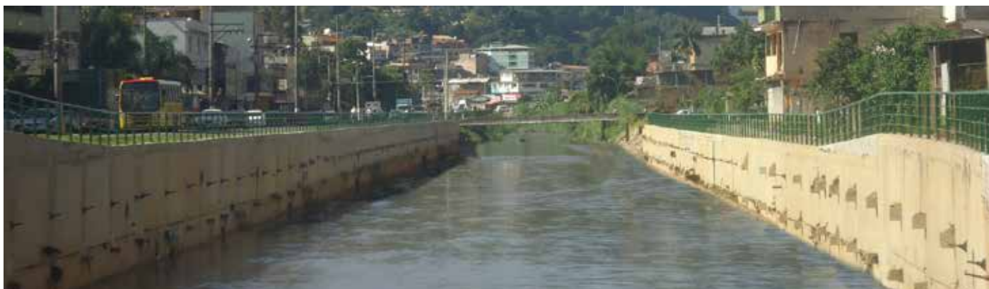
Canalização e dragagem na Bacia do Rio Bengalas, em Nova Friburgo (RJ)
