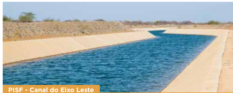
PISF - Canal do Eixo Leste
