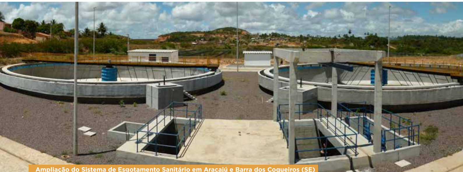
Ampliação do Sistema de Esgotamento Sanitário em Aracajú e Barra dos Coqueiros (SE)
