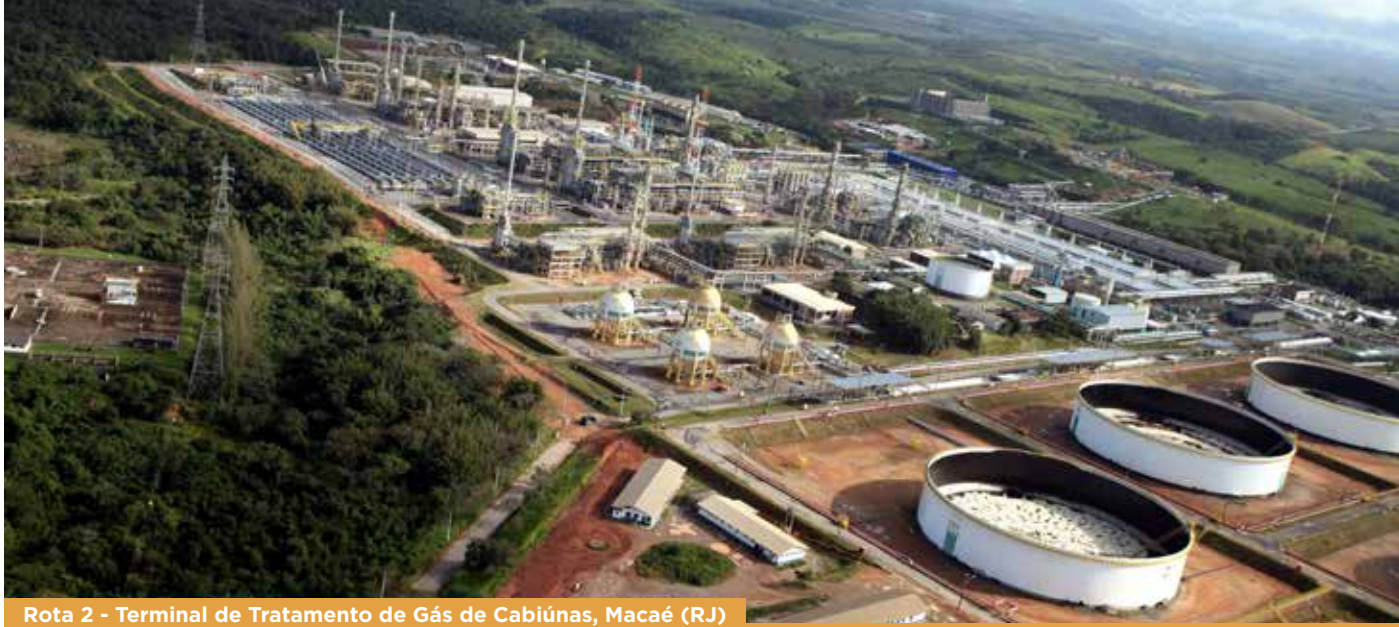
Rota 2 - Terminal de Tratamento de Gás de Cabiúnas, Macaé (RJ)
