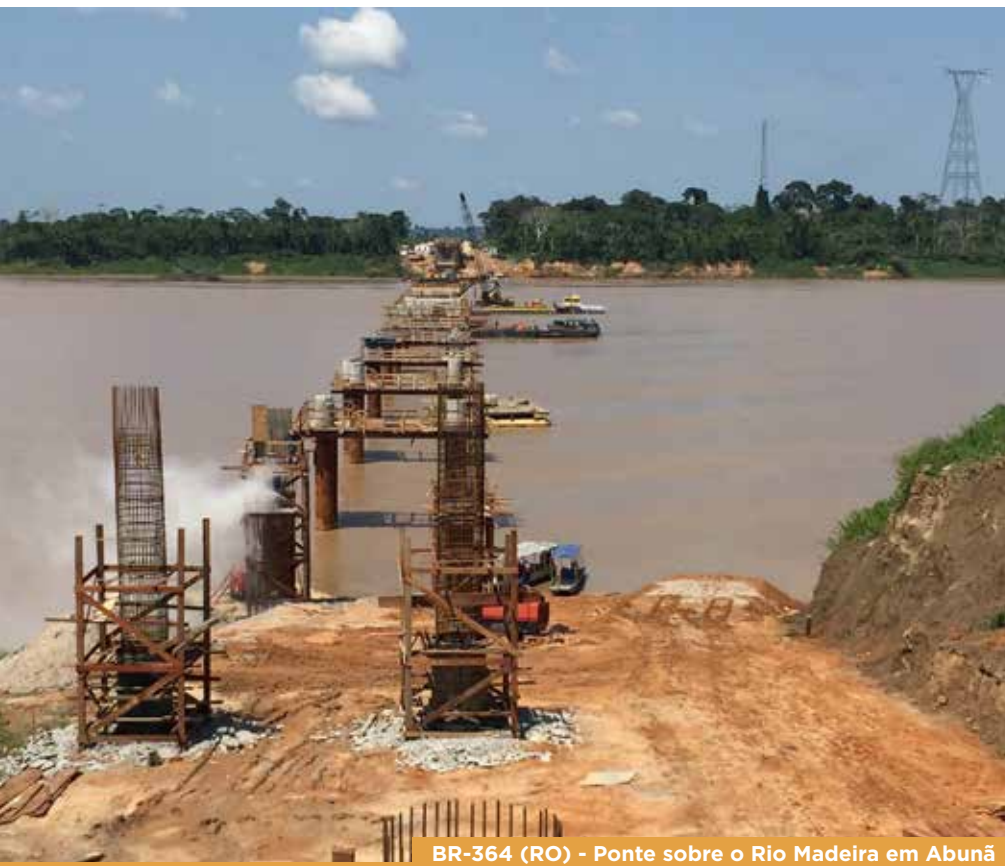
BR-364 (RO) - Ponte sobre o Rio Madeira em Abunã
