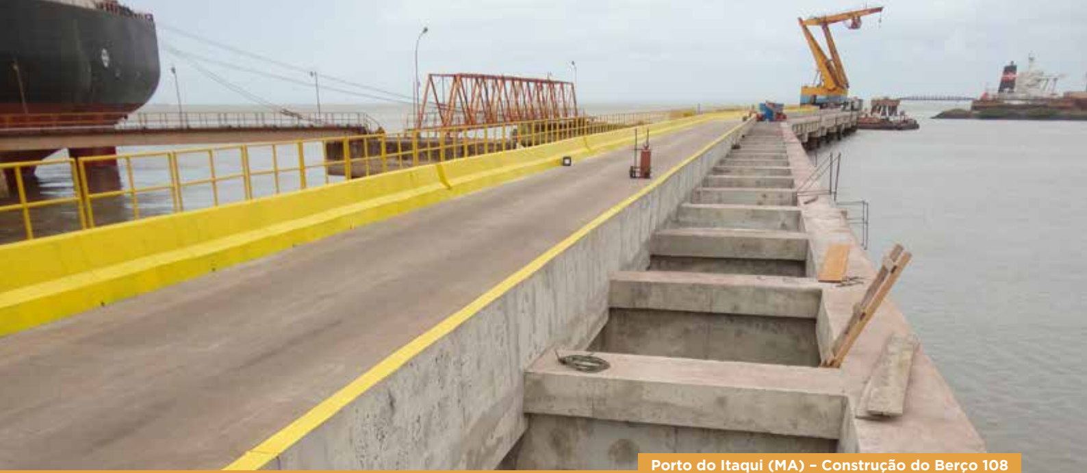
Porto do Itaqui (MA) - Construção do Berço 108
