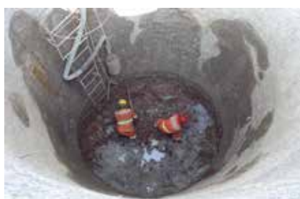
Sistema São João e Bonsucesso Execução do Poço de Serviço
