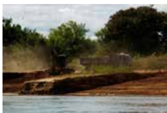
Recuperação de margens – Barra/BA
