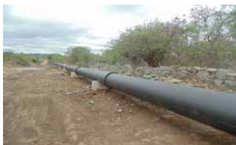
Assentamento de adutora ferro dúctil
