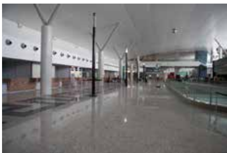
Reforma e ampliação do TPS
