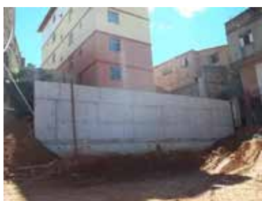
Contenção em construção – Pedreira Prado Lopes
