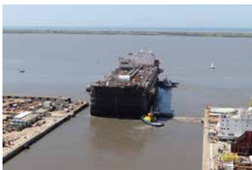
Lançamento do casco do FPSO P-66
