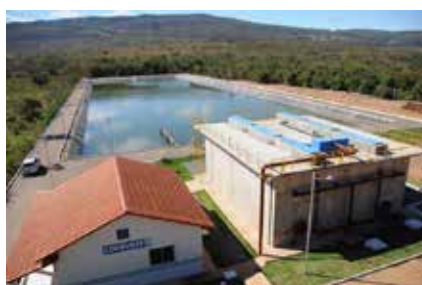
Estação de Tratamento de Esgoto de Icarai de Minas/MG
