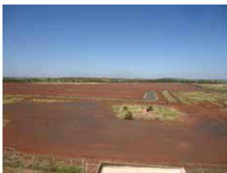
UFN V – Terraplanagem
