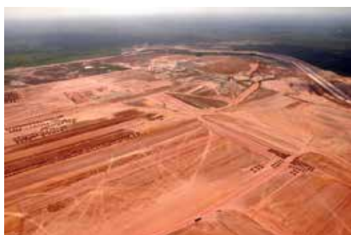
Terraplenagem da Refinaria Premium I
