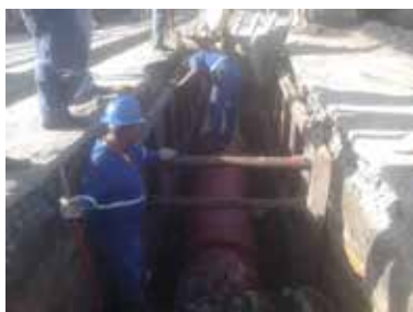
Via Mangue – Obras da Linha de Recalque
