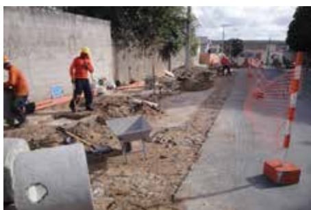
Bacia CE-06 – Rede coletora implantada na Rua Amâncio Pereira
