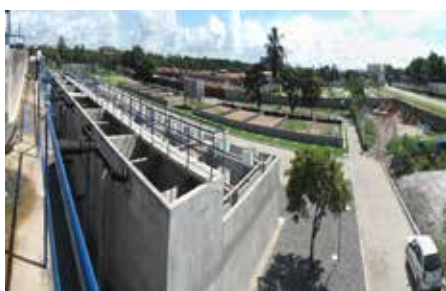
Vista da ETE ERQ Oeste
