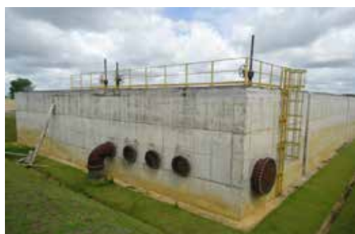
Reservatório Apoiado 5.000 m 3
