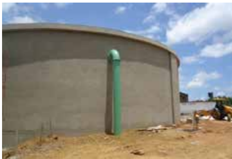
Construção do reservatório R14 em Salvador
