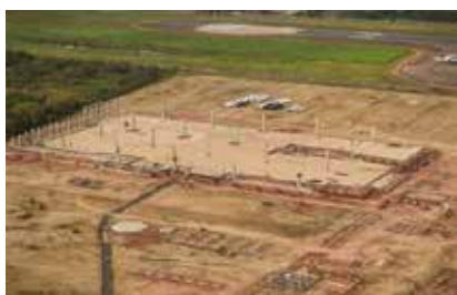
Construção do novo Terminal de Cargas
