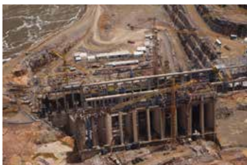
Casa de Força – Vista geral
