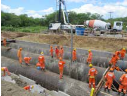
Assentamento de tubulação
