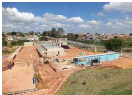
Obras do Centro Comunitário Jardim São Domingos
