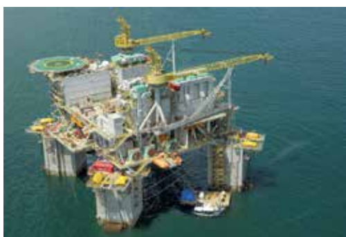
Plataforma P-61 na locação
