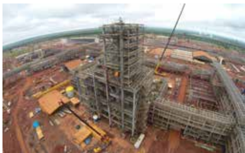
Montagem da Unidade de Ureia
