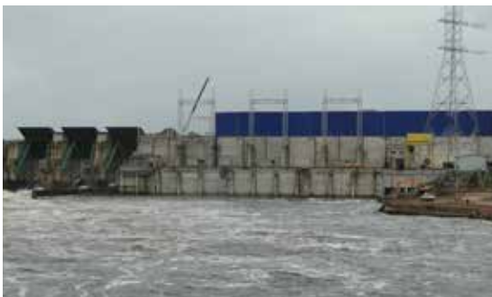
Casa de Força e Vertedouro – Vista de jusante
