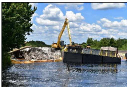
Figura 2-20: Abertura do canal principal.
