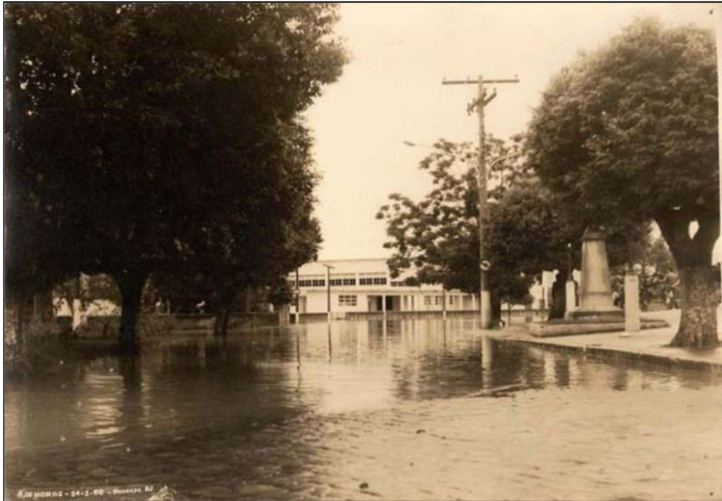
Figura 5-20: Inundação na área urbana de Resende em 1966. Disponível em < http://www.resendefotos.com.br >.
