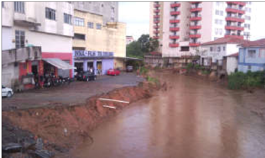
Figura 5-22: Destruição de calçamento e assoreamento provocados pelas chuvas de 2010. Foto do Autor.
