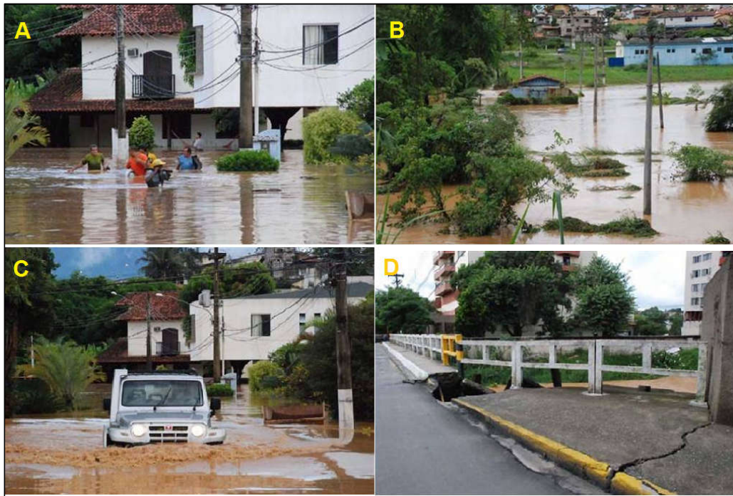
Figura 5-21: Imagens da enchente de março de 2010 mostrando o nível da água (A, B e C) e o estrago que a força da água causou na ponte na Av. Presidente Kennedy ao comprometer um de seus pilares. Fonte: Diário do Vale.
