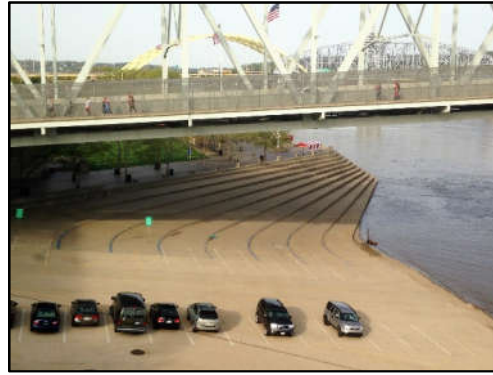
Figura 2-42: Rampa para barcos Cincinnati .
