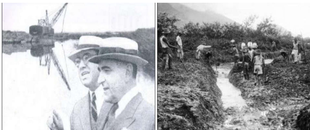
Figura 2-15: Visita do Presidente Getúlio Vargas às obras. Observa-se a abertura de canais de forma mecânica e manual.
