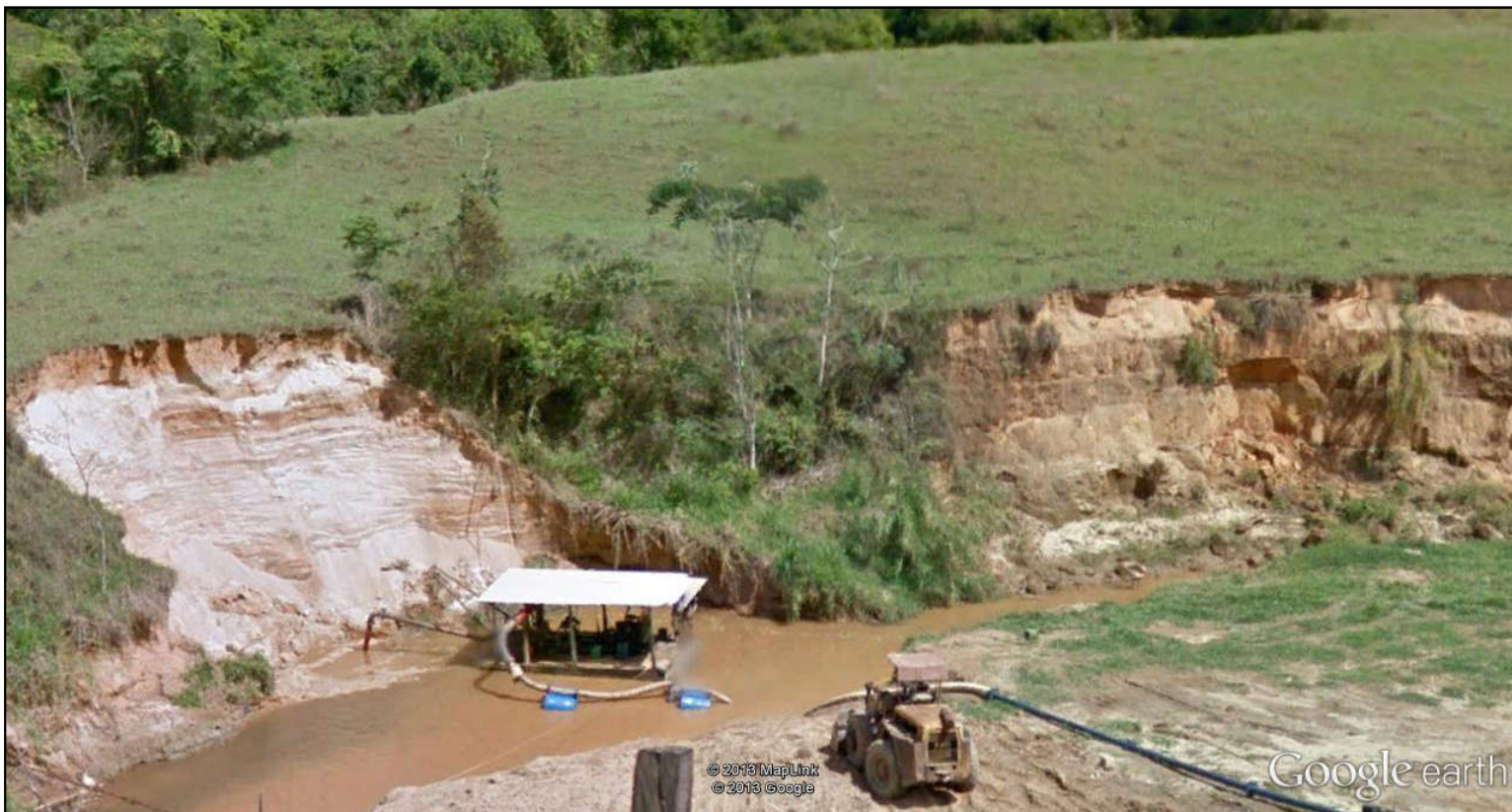
Figura 5-35: observa-se a draga extraíndo areia no pé do talude agravando a instabilidade das margens.
