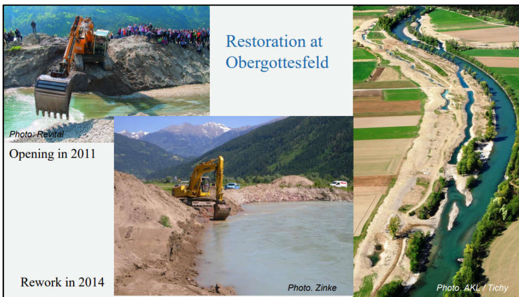
Figura 2-31: Intervenções realizadas para a restauração do rio em trecho na Áustria, 2011. http://www.ecrr.org/Portals/27/Events/ERRC2014/Presentations/29%20Oktober%202014/Plenary/Zinke.%20AT%20Drava%20in%20intl.%20corridor.29Oct.pdf .
