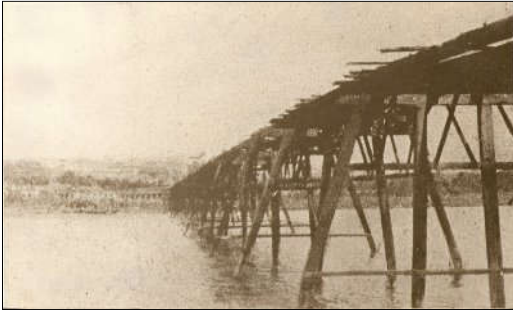
Figura 5-18: Ponte de madeira construída em 1824 e que foi arrastada pela enchente do Paraíba do Sul em 1833. Fonte http://arquivoresende.blogspot.com.br .
