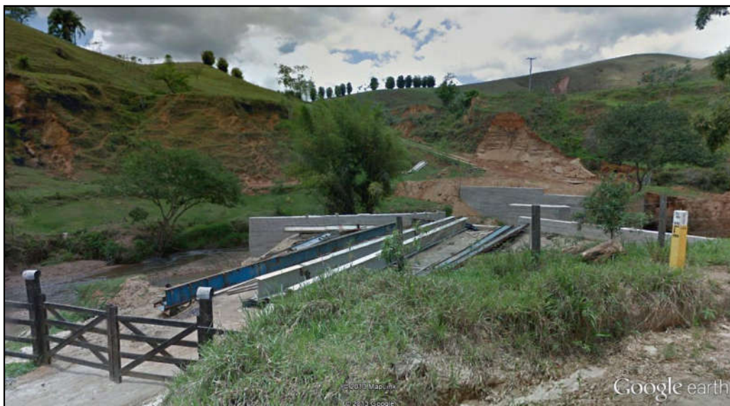
Figura 5-36: Observa-se construção recente de ponte identificada pelo Google Street View em 2012.
