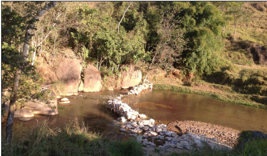
Figura 5-38: Foto tirada na inspeção do dia 30/08/2013, no mesmo local da foto anterior. Observa-se a agora rip-rap fazendo barramento do rio.
