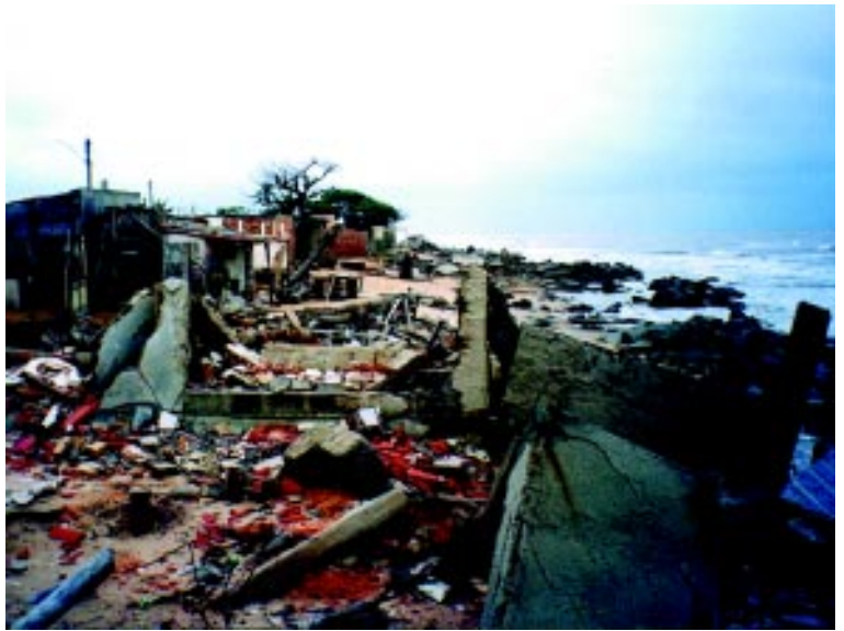
Figura. 13 Erosão e destruição da área urbanizada no pontal de Conceição da Barra (ES)
