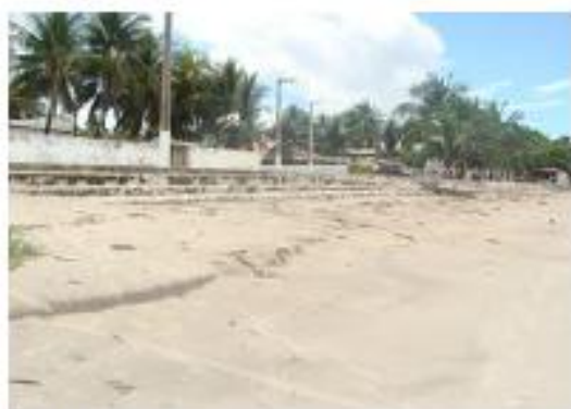
Muro de contenção
