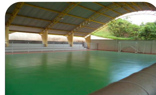
Construção de Quadra Escolar Coberta – Juiz de Fora/MG
