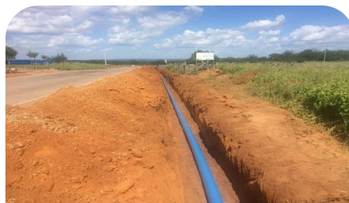
Adutora de Lagoa do Barro - Assentamento de tubulação – Lagoa do Barro do Piauí/PI
