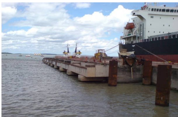
Cais do Porto de Itaqui
