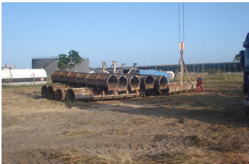
Fôrmas das estacas descarregadas no canteiro de obras
