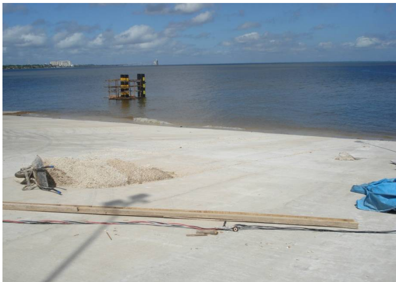
Vista da Rampa
