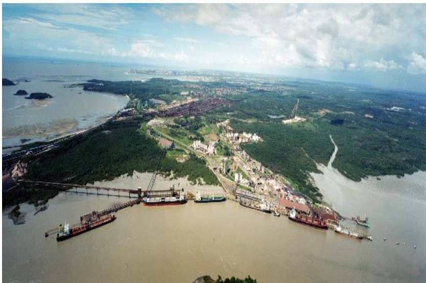
Cais do Porto de Itaqui
