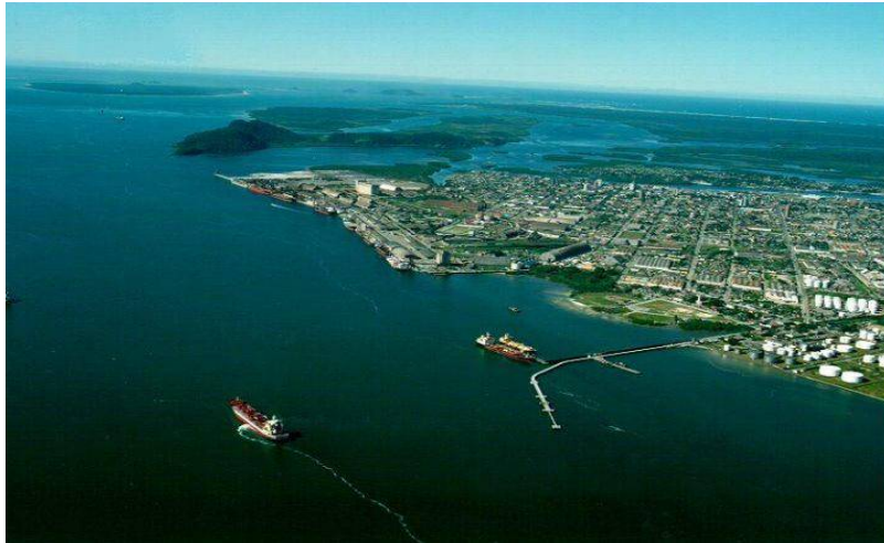
Porto de Paranaguá/PR
