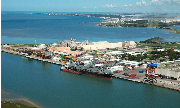
Cais Público do Porto Novo do Porto de Rio Grande
