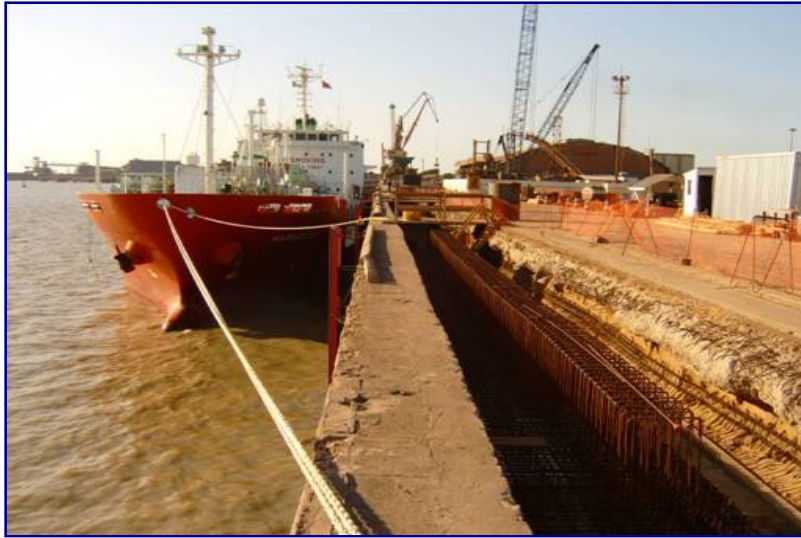
Cais do Porto de Itaqui
