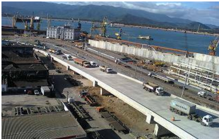
Viaduto do Paquetá
