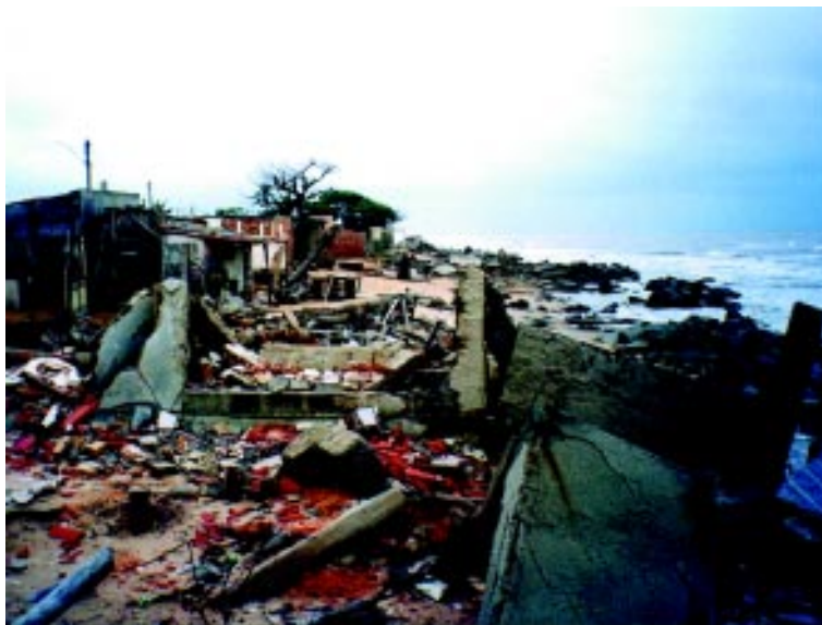
Figura. 13 Erosão e destruição da área urbanizada no pontal de Conceição da Barra (ES)
