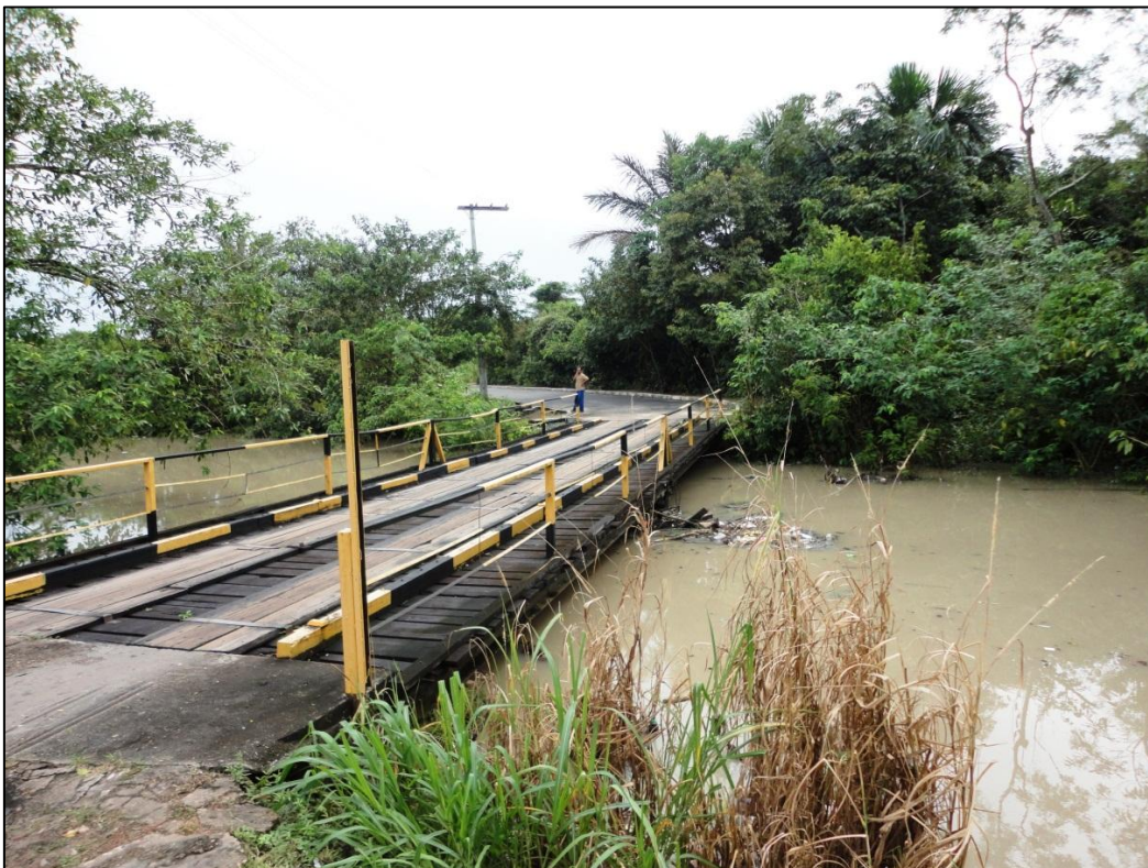
FIGURA. Ponte de acesso atual ao terreno do CMM.
