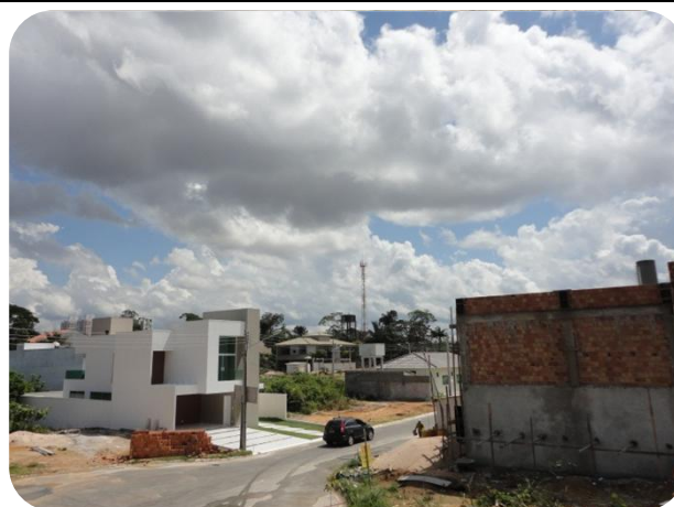
Foto – Obras no interior do condomínio em questão
