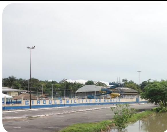
Foto 5.3.5.1-2 – Vista do Circulo Militar situado à Av. São Pedro
