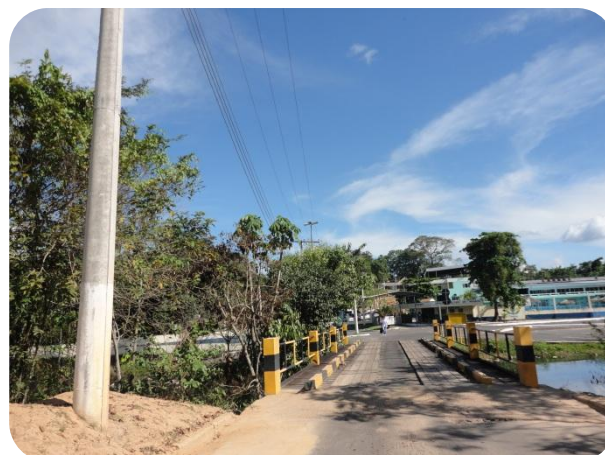
Foto 5.2.1-22: Ponte sobre o Igarapé São Jorge que dá acesso à área do empreendimento. A mesma é considerada inadequada para atender a futura demanda, já que possibilita a passagem de apenas 01 veículo por vez.
