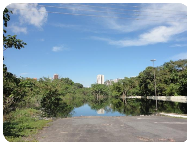
Foto 5.2.1-20: Vista do estacionamento do CIRMMAN, que se encontra parcialmente alagado pelas águas do Igarapé São Jorge, principalmente na estação chuvosa.
