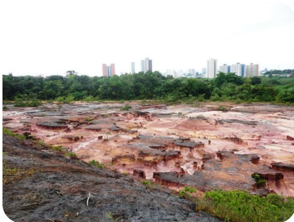
Foto 5.1.5-1 – Vista para processos erosivos instalados na área de implantação do empreendimento.
