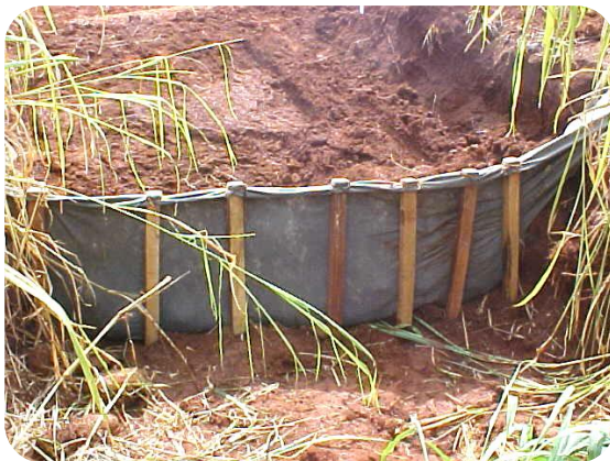
Foto 7.1-3 - Barreira de retenção de partículas, executada com manta geotêxtil.
