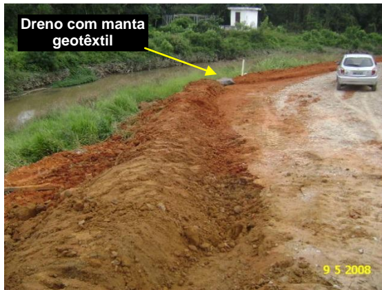
Foto 7.1-1 - Exemplo de leira de solo implantada para condução do fluxo das águas incidentes.
