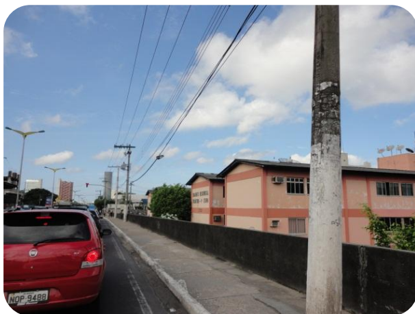
Foto 5.3.5.1-10 – Edifícios residências de médio a baixo padrão - Av. Constantino Nery
