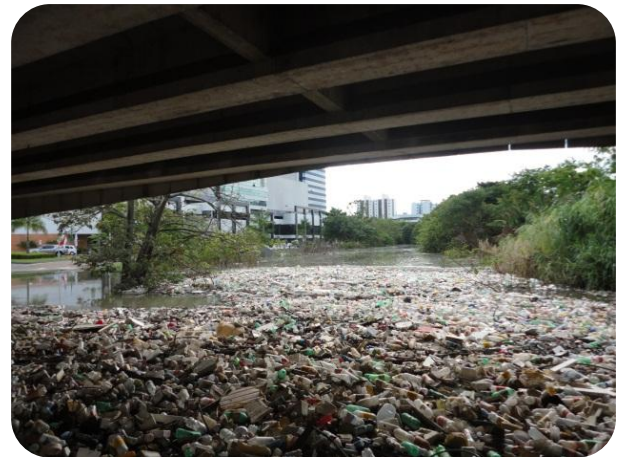
Foto 5.3.4-4 - Igarapé Mindu sob Ponte da Av. Constantino Nery, nas proximidades do Parque Ponte dos Bilhares.
