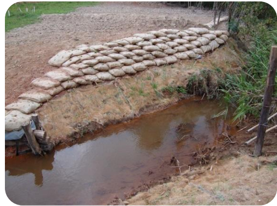
Foto 7.1-2 - Modelo de dispositivo contra o carreamento de material particulado para curso d'água.
