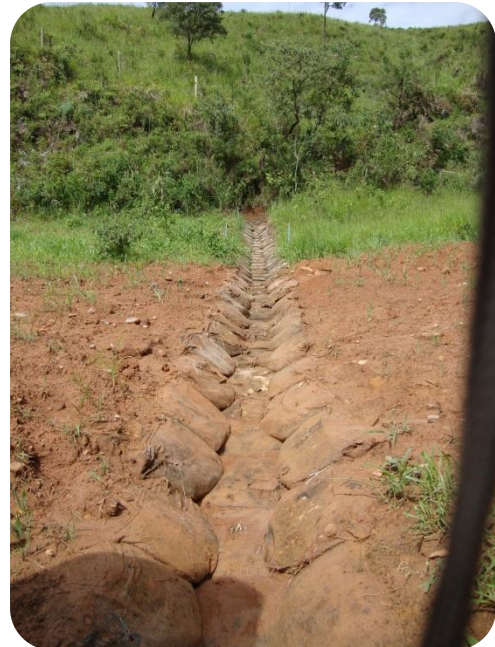
Foto 7.1-4 - Canaleta provisória constituída de sacos de solo.
