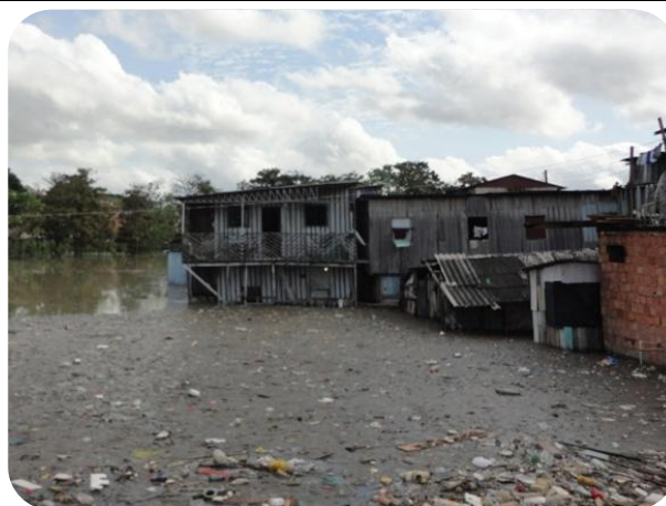
Foto 5.3.5-19 - Palafitas sobre o Rio Cachoeira Grande. Pode ser notada a excessiva quantidade de lixo que há no local – Vista da Av. São Jorge.
