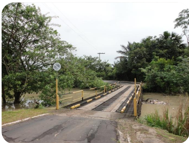
Foto 5.2.1-25: Vista da ponte sobre o Igarapé dos Franceses e de sua respectiva APP.
