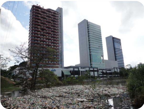
Foto 5.3.4-3 - Edifícios residenciais de alto padrão e o acúmulo de lixo no Igarapé Mindu, nas proximidades do Parque ponte dos Bilhares .
