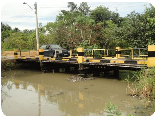
Foto 5.2.1-21: Detalhe da ponte de madeira sobre o Igarapé São Jorge, que dá acesso ao empreendimento. Ao fundo, nota-se vegetação de baixio em Área de Preservação Permanente.
