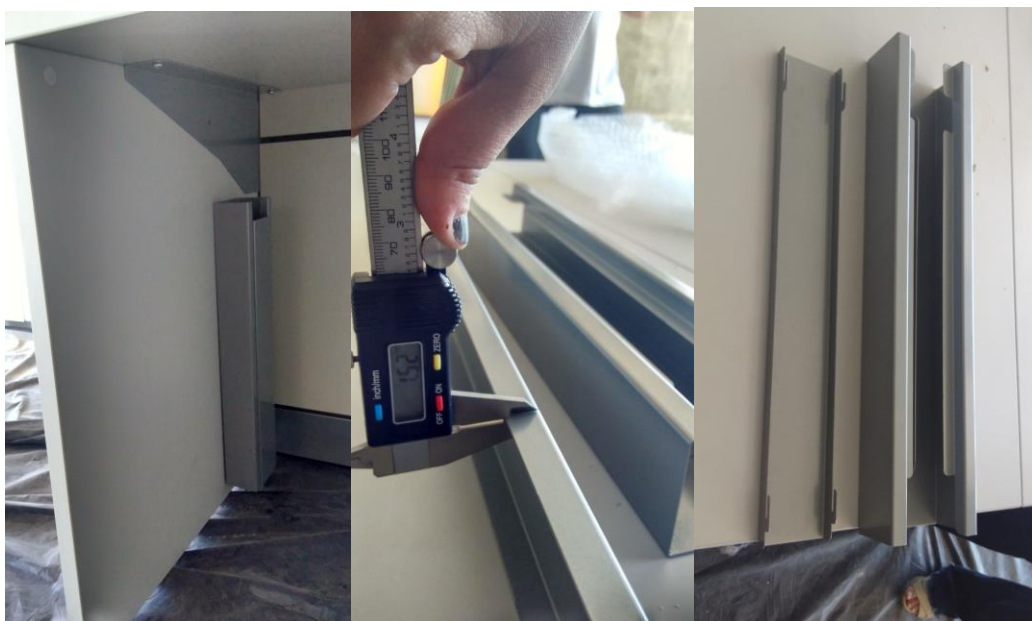
Figuras 07, 08 e 09 – Calha para passagem de fiação na base lateral.
